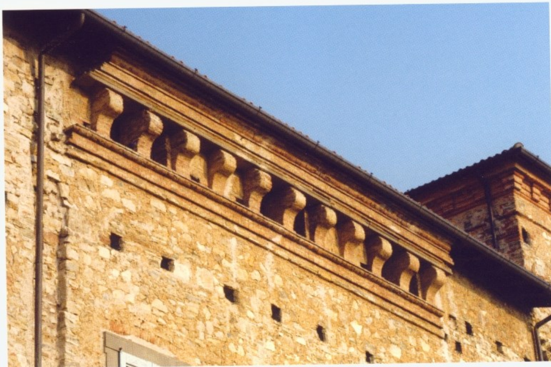
Mensoloni del sottogronda in un tratto di facciata
